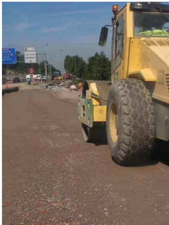
Compactación de la explanada. Tramo de prueba del Txorierri.
