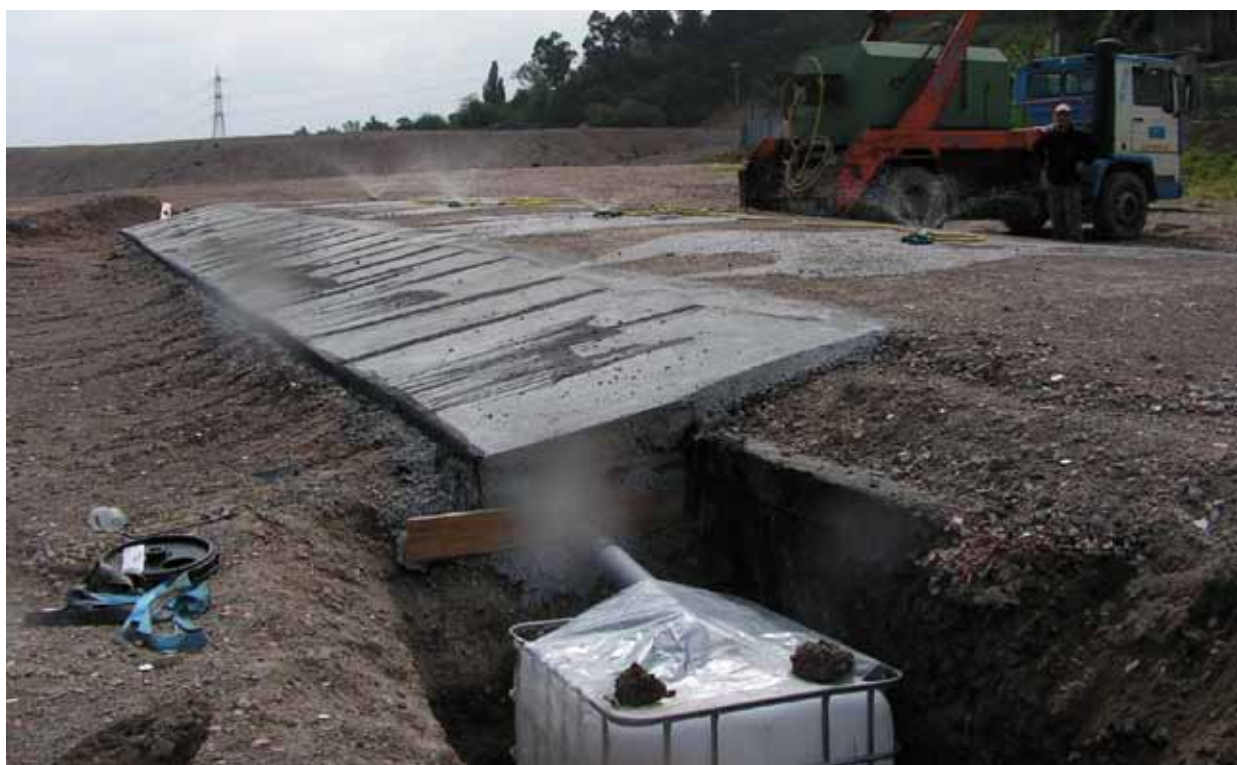
Figura 30. Tramo de prueba de la Orkonera.
