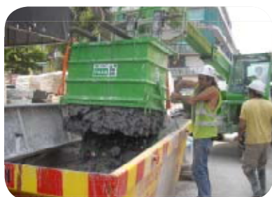
El barro del pulido hay que separarlo del escombros limpio
