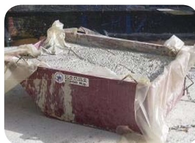
Hay que acopiar debidamente el hormigón sobrante de homrigonado
