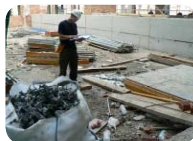
El TMA realizando un Control de Obra
